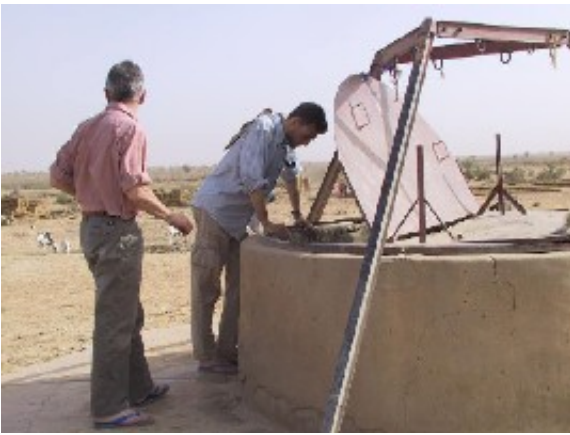
Illustration 23: Puits aménagé au Sénégal (source HSF)
