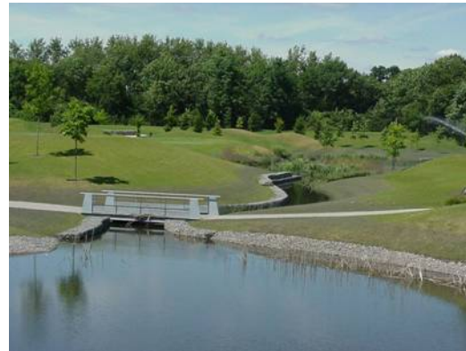
Bassins d'infiltration ou de stockage
