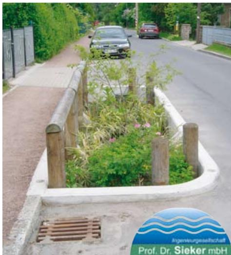
► [Fig. 3] Technique alternative au réseau d'assainissement (BMP) décrites dans l'ADSS : ralentisseur de circulation en zone résidentielle, bassin de stockage et d'infiltration des eaux de ruissellement pluvial (Hoppegarten, banlieue de Berlin, réalisation IPS, partenaire scientifique de DayWater).
