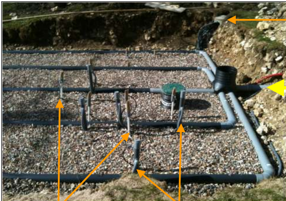
Photo 2 : Massif filtrant et instruments du site pilote avant remblais
