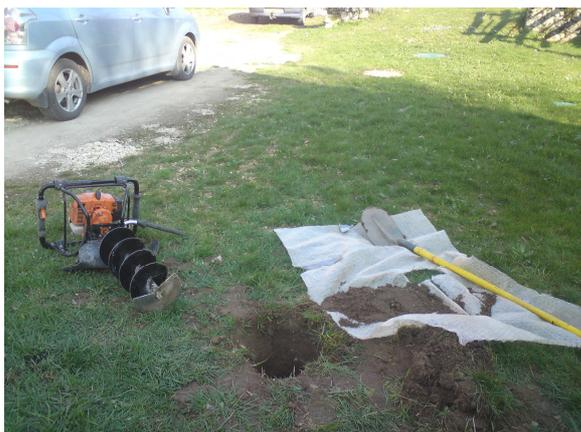
Photo 4 : Trou avec la tarière thermique
