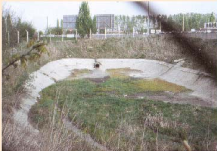
Bassin du centre commercial Cora
