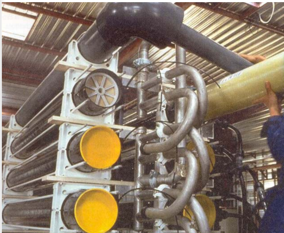
Changement d'un module de membranes de nanofiltration
