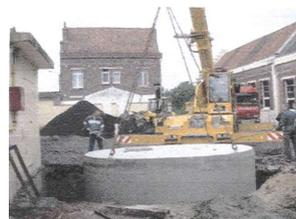
Cuve en béton enterrée
