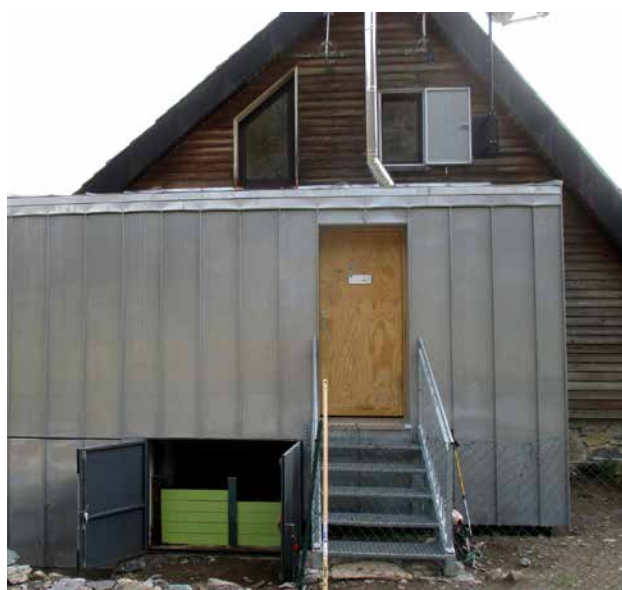
FIGURE 7 Bloc sanitaire du refuge d'Ayous.
