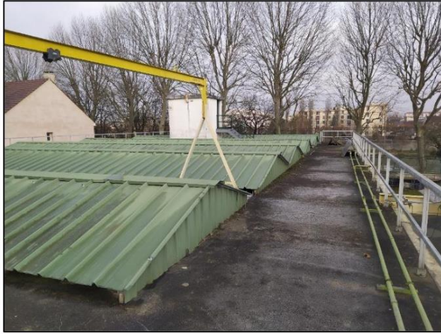
Figure 4 : vue des toits des 2 décanteurs
