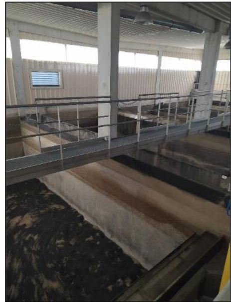
Figure 7 : Filtre après enlèvement de la couche de charbon actif en grains
