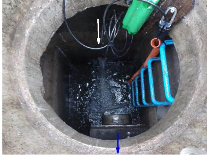
Figure 29: Photo du point de mesure 211 avec le limiteur Vortex (sonde piézométrique dans le fourreau)
