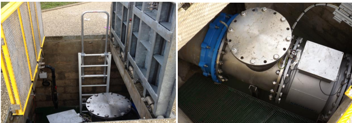
Figure 20 : Photo du débitmètre avec la trappe de visite à l'amont
