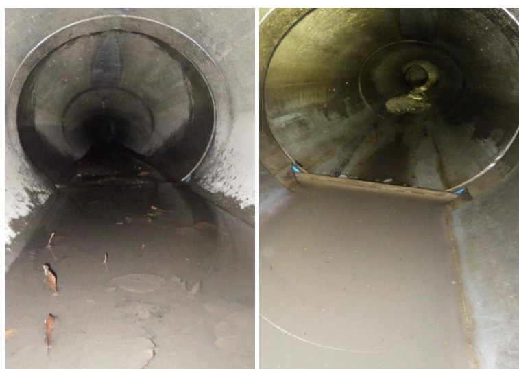
Photo : Etat d'ensablement – point 197 - Vers Aval - avant (gauche) et après (droite) nettoyage
