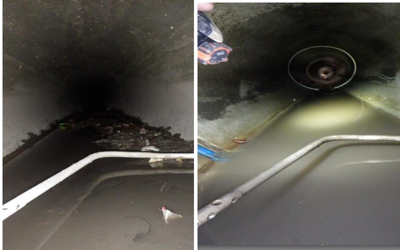
Photo : Etat d'ensablement – point 197 – Vers Amont - avant (gauche) et après (droite) nettoyage
