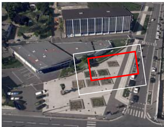
Figure 4: vue aérienne des bassins de stockage et de dépollution
