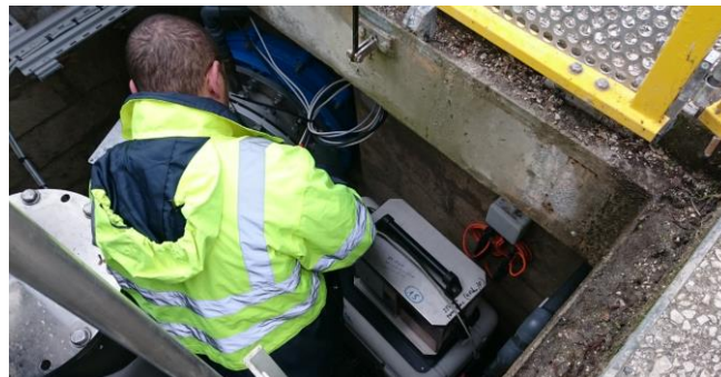
Figure 24 : Photo du préleveur dans la chambre du débitmètre électromagnétique
