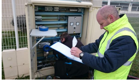
Figure 21 : Photo de l'armoire électrique du point 197
