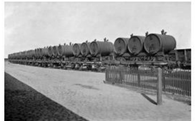
Fig. 13 Exemple de gestion des excréta humains avant la mise en place du tout à l'égout à Copenhague Source : Sørensen, 2006
