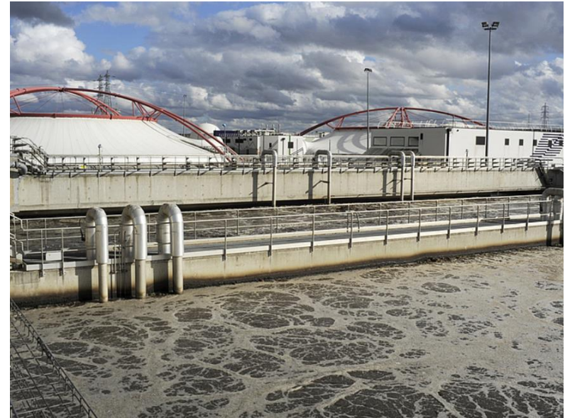
Bassin de nitrification de la STEU Seine-Amont du SIAAP, localisée à Valenton. Source : siaap.fr
