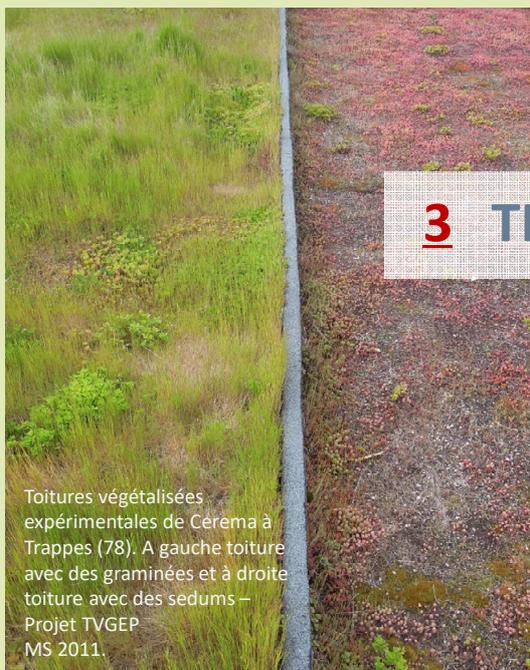
Toitures végétalisées expérimentales de Céréma à Trappes (78). A gauche toiture avec des graminées et à droite toiture avec des sedums – Projet TVGEP MS 2011.
