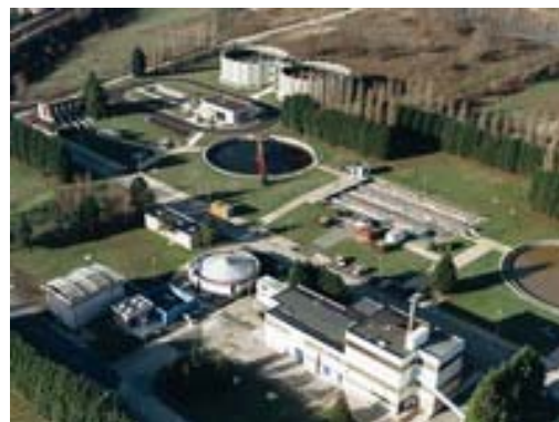
Station d'épuration Seine Centre
