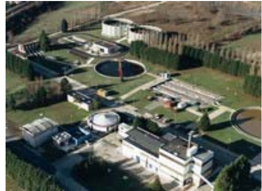
Station d'épuration Seine Centre
