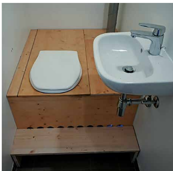
FIGURE 13 Immeuble de l'Eco-Quartier des Vergers (a) et toilettes sèches à carrousel (b).
