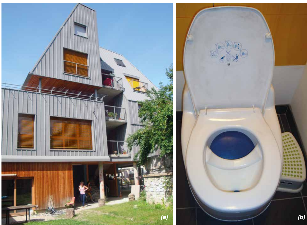
FIGURE 11 (a) Immeuble d'habitat participatif Au Clair du Quartier à Grenoble, équipé de toilettes sèches séparatives. (b) Toilettes sèches séparatives installées dans chaque logement. Source : B. de Gouvello.
