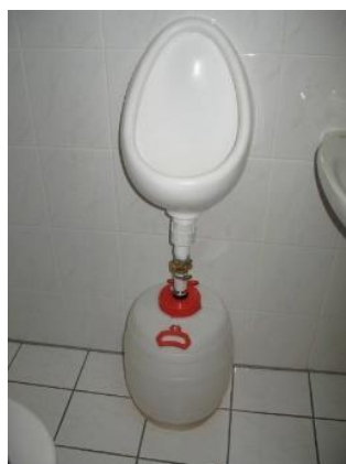
Figure 20 : Urinoir « Addicom » avec membrane EcoSmellStop (qui ne semblent plus être commercialisés ?) relié à un bidon de 20L. Source : Sustainable Sanitation on Flickr , Témoignage sur le Susana Forum . Crédit : Elisabeth von Muench.
