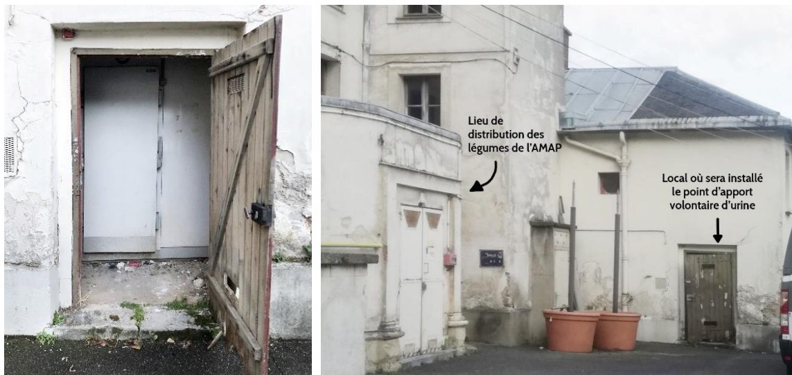
Figure 46 : Photo du local « abandonné », à côté du point de distribution des légumes.
