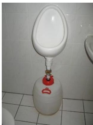
Figure 20 : Urinoir « Addicom » avec membrane EcoSmellStop (qui ne semblent plus être commercialisés ?) relié à un bidon de 20L. Source : Sustainable Sanitation on FlickrR , Témoignage sur le Susana Forum . Crédit : Elisabeth von Muench.
