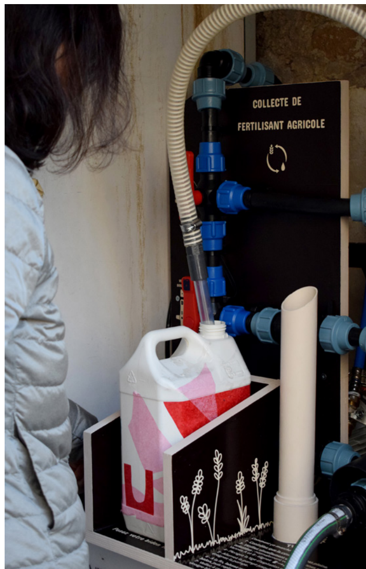
Station de transvasement au point d'apport volontaire d'urine. 1 = Espace pour poser le bidon 5L ; 2 = Tige d'aspiration à plonger dans le bidon ; 3 = Support de la tige d'aspiration ; 4 = Vannes pour choisir le sens de transvasement (à manipuler uniquement par la ferme) ; 5 = Deux cuves d'urine de 130L.
