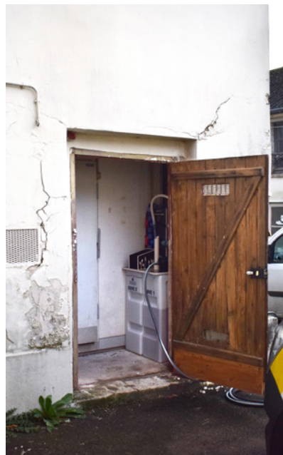
Vue du local depuis l'extérieur
