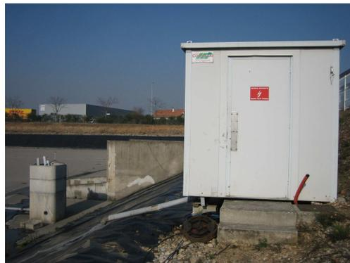
Figure 20 : Accès facilité aux appareils de mesures dans un local technique proche du point de mesure sur le site de Chassieu à Lyon (INSA de Lyon – site de l'OTHU)
