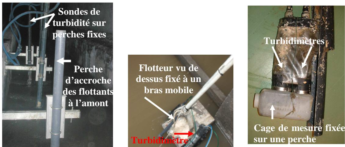
Figure 13 : Systèmes d'installation et de protection des sondes contre les déchets flottants, perche d'accroche (gauche, site des Quais à Paris), flotteur (milieu, site de Maxeville à Nancy), cage de mesure (droite, site de Duchesse Anne à Nantes)
