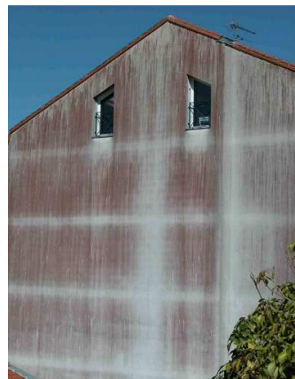
Figure 1 : Exemples de développements biologiques sur les surfaces de bâti
