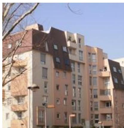
**Figure 92 : Exemple des toitures-terrasses avec des brisis en bardeaux bitumeux- Quartier L'Ormetteau**
