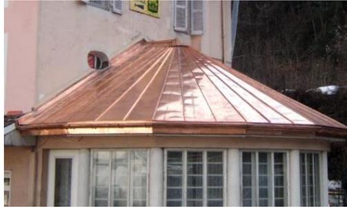
**Figure 14 : Toiture en cuivre**
