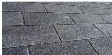
**Figure 18 : Exemple de bardeaux bitumeux**
