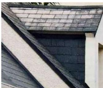
**Figure 12 : Ardoise en fibres ciment blanchie**
