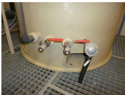
Figure 28 : Point de prélèvements situé au fond des cuves
