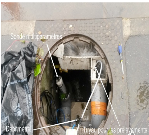
Figure 4 : Dispositif de mesure dans l'avaloir (photo Cerema)
