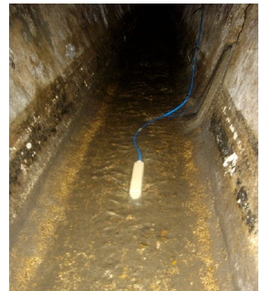
Figure 5 : Débitmètre de l'exutoire 1 (photo Cerema)
