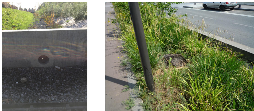
Figure 1.11 – Exemples de rejet via un dispositif de régulation (à gauche) (à Neuilly-sur-Marne) et d'évacuation au réseau en dessous du niveau du radier de l'ouvrage (à droite) (à Vitry-sur-Seine) (Source: M-C. Gromaire)
