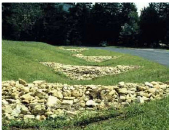
Figure 4: Noue enherbée divisée en biefs (Clar et al., 2004)
