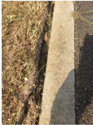
Figure 105 : Exemple de rétractation du sol à la jonction entre une noue et le bord de la chaussée à Torcy (Gromaire, 2018b)
