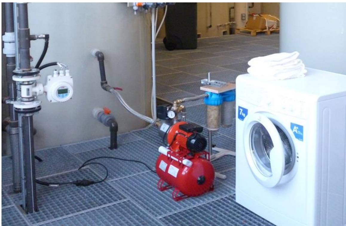
Figure 4 : Dispositif expérimental permettant l'alimentation d'un lave-linge par de l'eau de pluie préalablement filtrée
