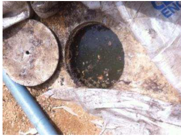
Fosse septique « ronde »
