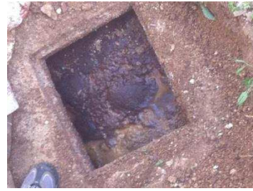
Fosse septique « carrée »
