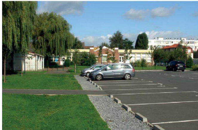
Tranchée drainante (Sage, 2016)
