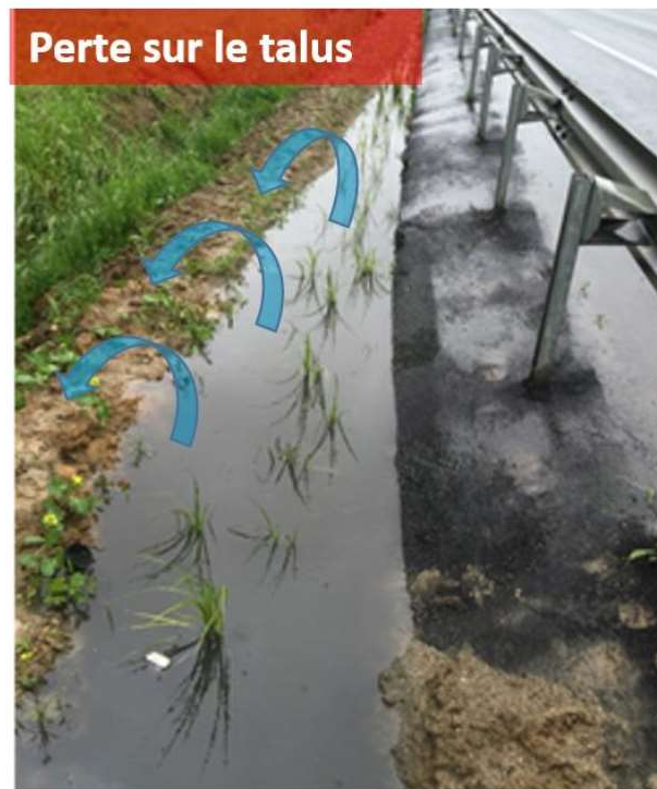
Figure 17 Photo de la noue filtrante montrant une possibilité de perte d'eau sur le talus (pris de Kanso, 2018)
