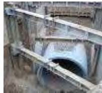
Béton de réseau
