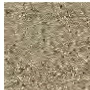
Béton de trottoir et dalle en béton
